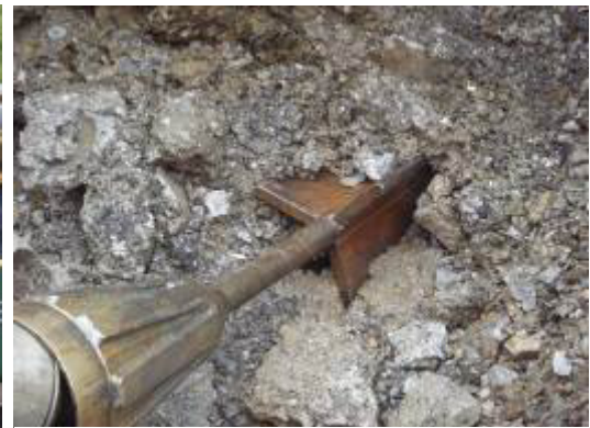
El cortador de 3 hojas rompe el antiguo tubo de hormigón.
