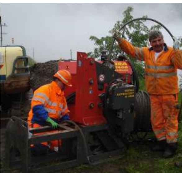
El cable de tracción es deslizado por intermedio del Equipo de Cracking a través de la tubería antigua.
