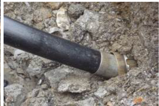
El cono expansor desplaza la antigua tubería hacia un lado produciendo una expansión mayor del terreno para la nueva tubería.
