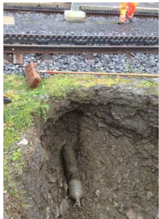
La nueva tubería está instalada.
