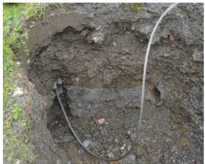
El cable de tracción es deslizado por intermedio del Equipo de Cracking a través de la tubería antigua.
