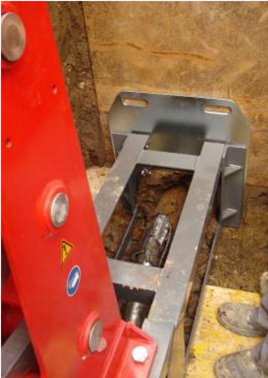
El cuchillo cortador giratorio en el pozo donde está la máquina.
