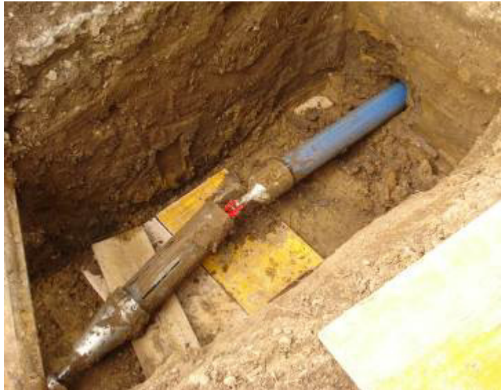
El cable burster es despalzado hacia atrás del pozo, de modo que el cono de expansión y la nueva tubería se pueden desmontar. El nuevo tubo puede ser conectado al sistema de agua fresca.
