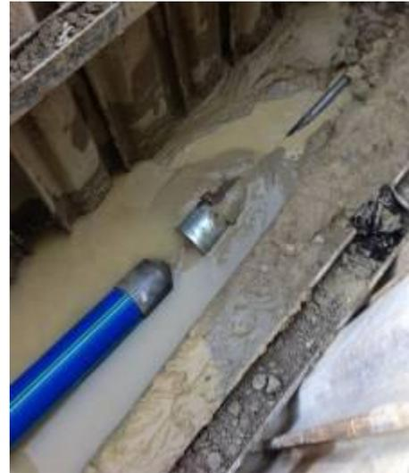
La perforación piloteada ha terminado. El material constaba de arcilla, grava y algunas piedras. Un cabezal de 3 dedos fue utilizado como cabeza de la broca. La cabeza de la broca se desmonta. A continuación, el escariador se ensambla.
