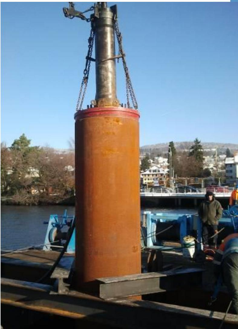
La TERRA-HAMMER TR 360 hinca la tubería de acero de  $\varnothing$  1000 mm (40 ") en el lecho del lago.
