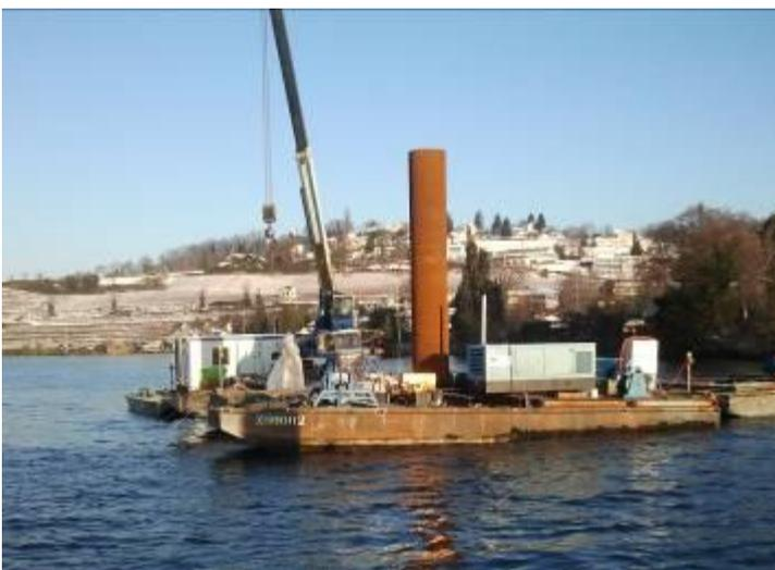
Después de que el pontón había llegado a la zona de trabajo, la tubería de acero se puso en posición vertical y ajustado a plomo. Ahora la TERRA-HAMMER TR 360 podía hincar el tubo de acero hacia abajo en el lecho del lago. A continuación, el nuevo tubo de acero y el viejo pilote estaban conectados mediante un marco de acero soldado
