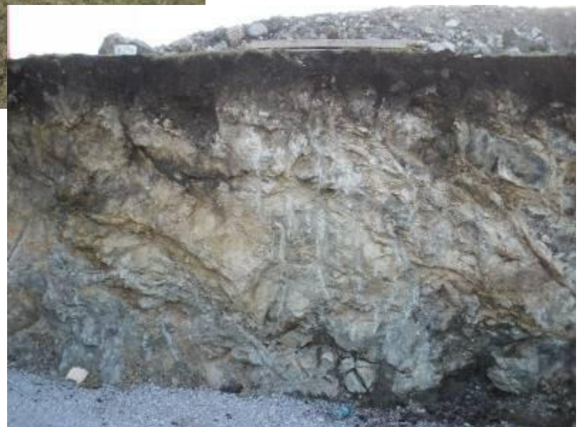
→ El suelo rocoso comenzó a una profundidad de 0.5 – 8 m el encamisado fué introducido entre 1-9 m.
