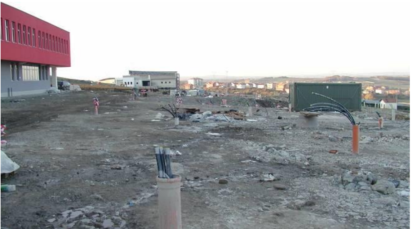
Vista de las primeras 15 perforaciones. Las 15 primeras sondas se asoman del terreno.
