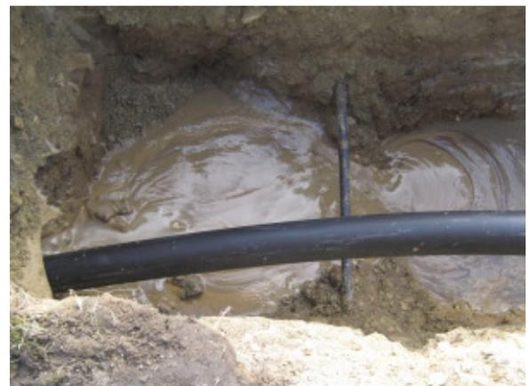
Lodo de Bentonita es continuamente expulsado fuera de la perforación durante la instalación de la tubería.
