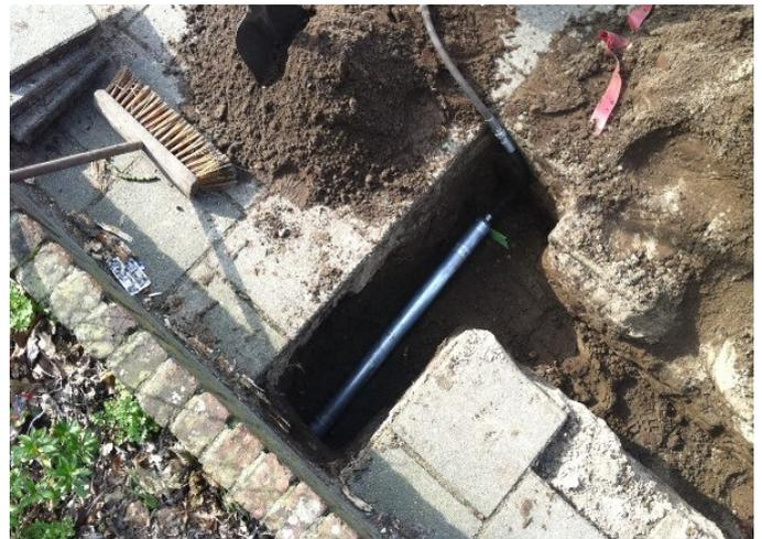
The TERRA-HAMMER T 055 SK penetrates into the ground. El TERRA-HAMMER T 055 SK penetra en el suelo (terreno).
