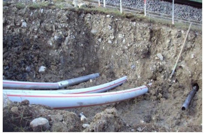
Los tres primeros tubos están instalados. El TERRA-HAMMER es preparado para el siguiente paso.
