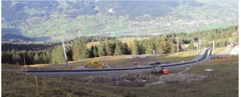
Vista de un sitio de trabajo. Cuatro tubos son colocados debajo de la vía férrea. Al fondo usted puede ver el pueblo de Grindelwald
