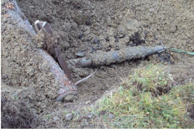
El TERRA-HAMMER con el expansor y la nueva tubería de HDPE al término del cruce.
