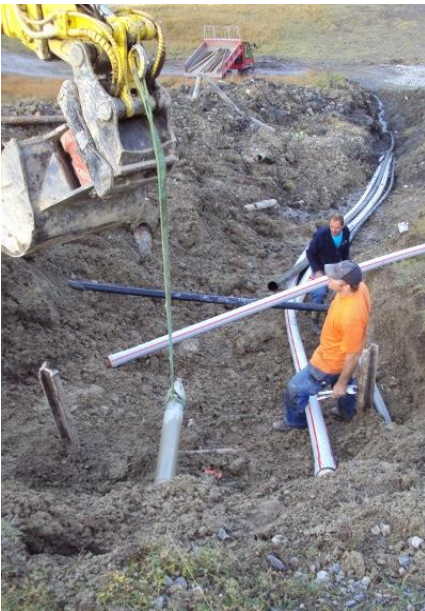
El TERRA-HAMMER con el expansor y la nueva tubería de HDPE al término del cruce.
