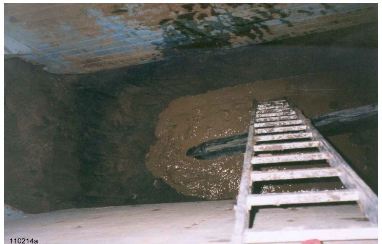
Foto abajo derecha: Introduciendo el tubo de PE desde la fosa de destino (profundidad 4 m) sin ensanche intermedio. Cabezal ensanchador: Ø 260 mm
