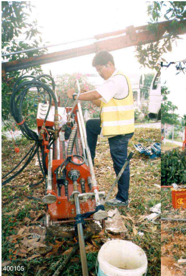
Fotos izquierda y abajo: La TERRA MINI-JET/LV en el paso por debajo de un río de un largo de 60 m.
