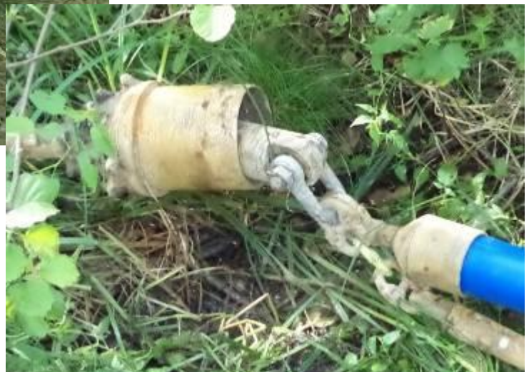
→ Der Aufweitkopf \varnothing 260 mm mit den beiden HDPE-Rohren DA 110 mm und DA 63 mm kurz vor dem Rohreinzug.
