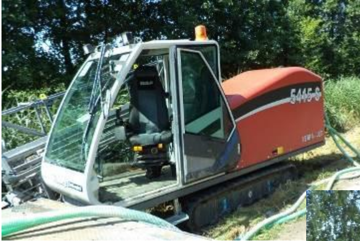
← Der TERRA-JET 5415 S in der Startposition der 240 m langen "See-Bohrung".
