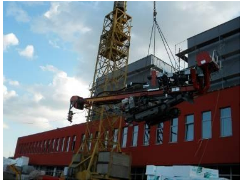
← Der TERRA-JET 4407 V wird mit dem Kran abgeladen. Er wiegt nur 1.8 to. ↓
