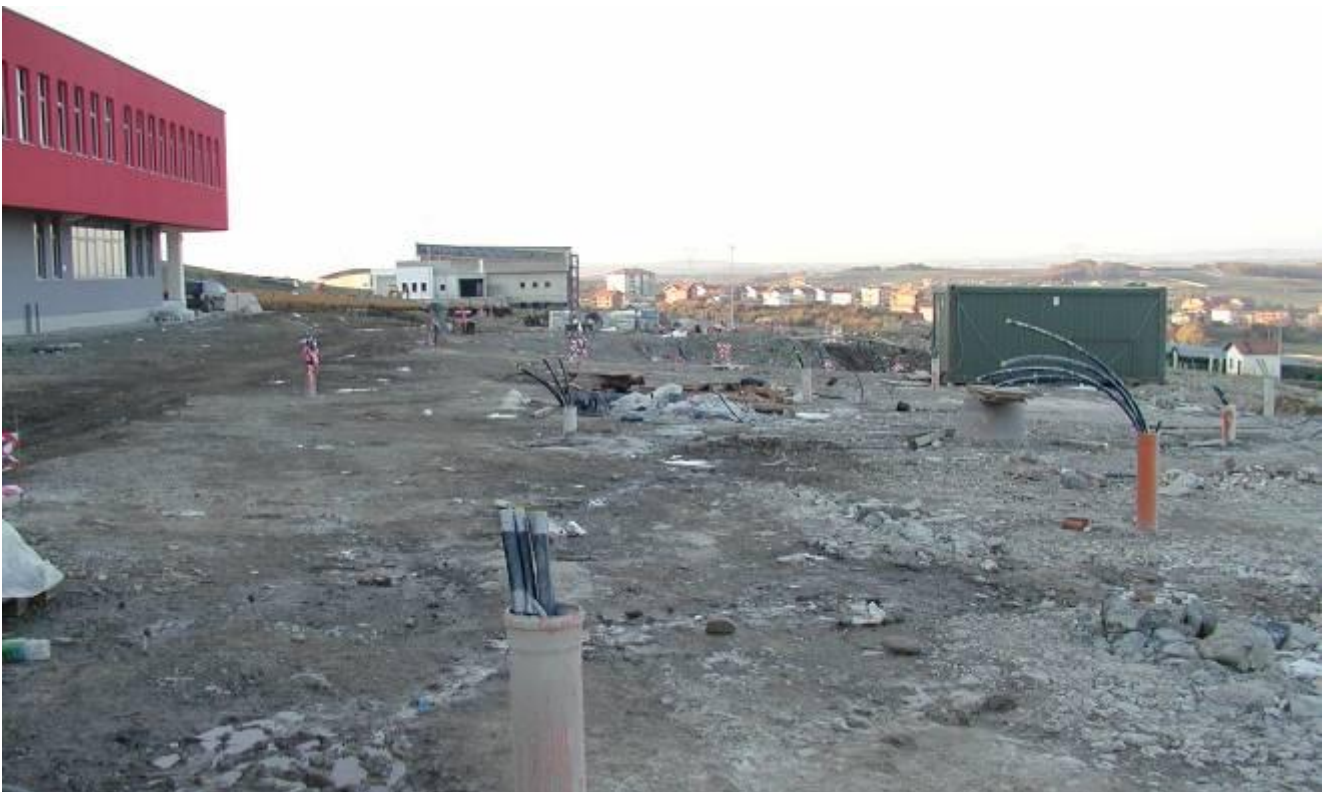
Blick auf die ersten 15 erfolgreichen Bohrungen. Die ersten 15 Erdsonden schauen aus dem Erdreich heraus.
